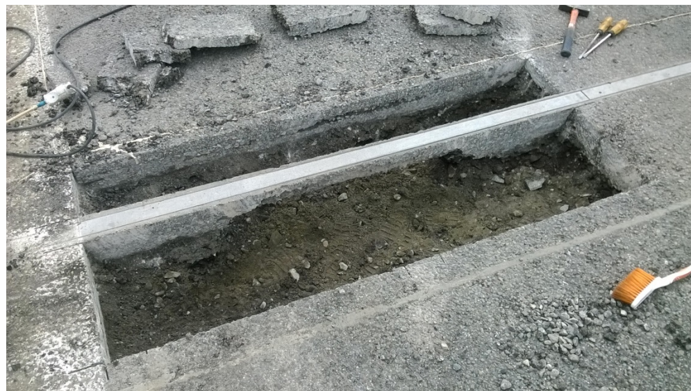
Ремонт покрытия в районе датчика
